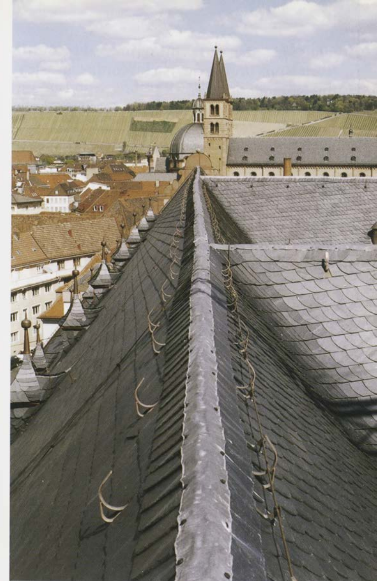
Abb. 3 Dachfirst des Westflügels mit der Visierung auf den Gebäudekomplex Dom – Neumünster. Durch die Visierung wird der Baukörper geschwenkt und auf den Dom ausgerichtet. Die maßgebende Visierlinie ist nicht der First, sondern die Gebäudeflucht des Westflügels im Innenhof. Foto: Universitätsbauamt
