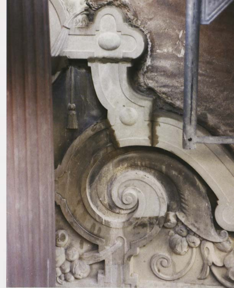
Abb. 3 Das Foto zeigt das Rollwerkornament am Hauptportal nach der Überarbeitung durch den Steinmetz. Foto: G. Flierl
