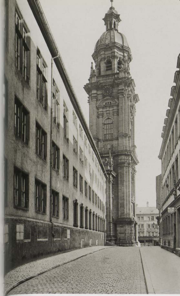
Abb. 6 Schönthalstraße (ehem. Schul-Gasse) mit Blick auf den Neubauturm. Obwohl die enge Gasse eigentlich keine sinnvolle Platzbildung zuläßt, ist der Neubauturm weit in die Straße hineingerückt. Foto: Bildarchiv Marburg
