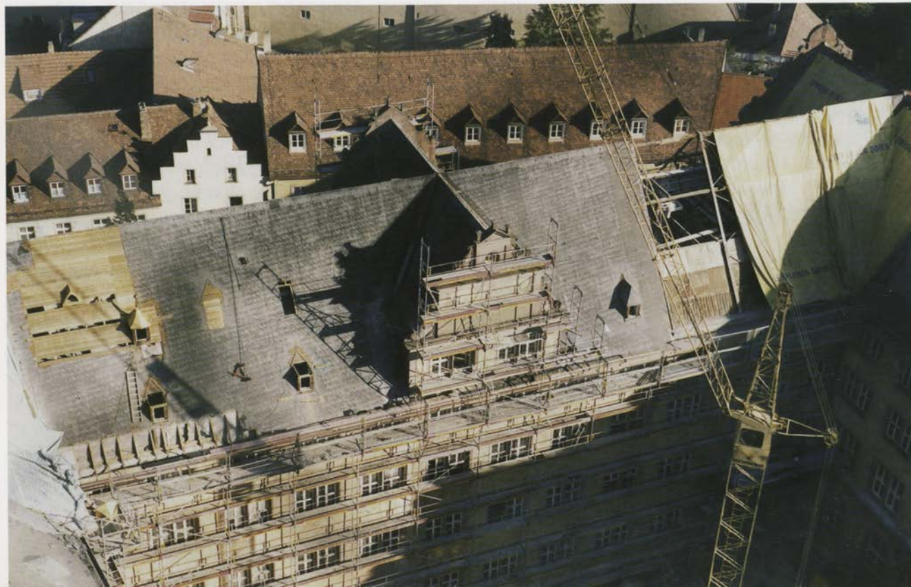
Abb. 2 Decken und Wände der Büchermagazine im 4. Obergeschoß des Nordflügels werden durch eine, in der Dachneigung abgeschrägte, Stahlbetonkonstruktion feuersicher gemacht. Foto: G. Flierl
