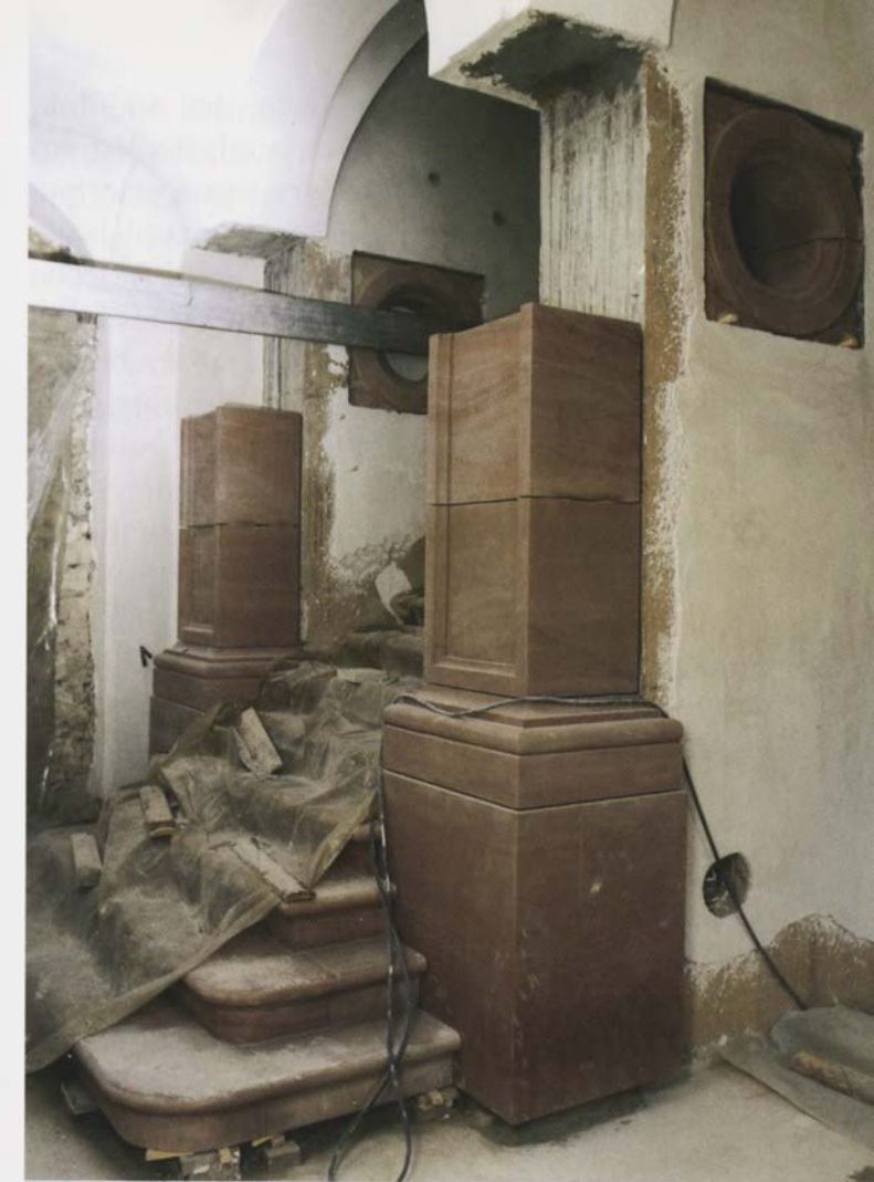
Abb. 7 Bei dem neuen Treppenhaus zwischen dem Westflügel und der Neubaukirche griff man gestalterisch auf die ursprüngliche Renaissance-Treppenanlage mit Mauerzungen, profilierten Werkstein-Mauerpfeilern, -Blockstufen und überwölbten Treppenläufen zurück
