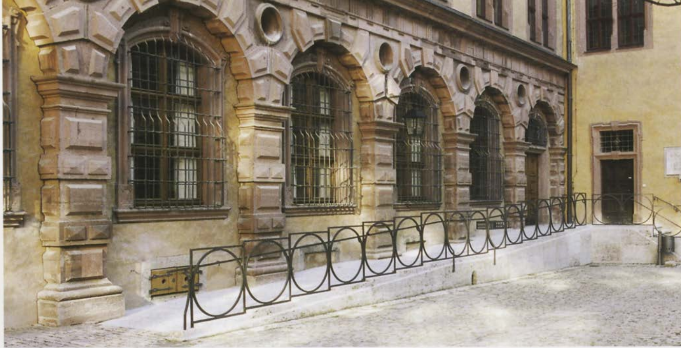
Abb. 8 Die Rampe für Rollstuhlfahrer vor dem Eingang im Südflügel: Ein neues funktionelles Bauteil im historischen Innenhof, das mittels der Baumaterialien, Muschelkalkwerksteine und Schmiedeeisen dem Ensemble angepaßt wurde.
