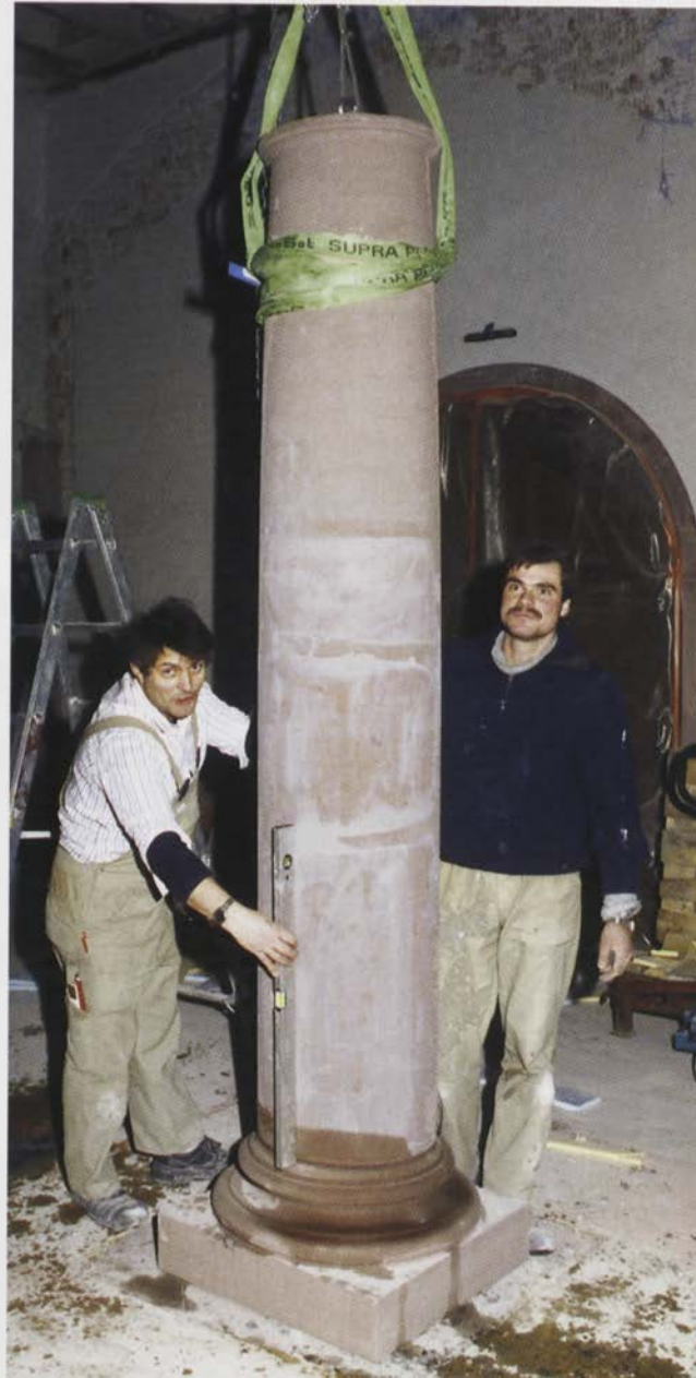
Abb. 9 und 10 Die Fotos zeigen den Bibliothekssaal während der Bauarbeiten. Der Säulenschaft wird mittels Seilzug auf die Basis versetzt (links). Fotos: Universitätsbauamt
